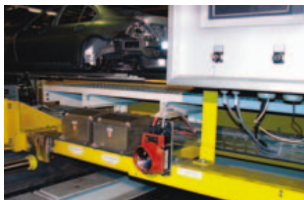
Transmission des données sur wagon à déplacement latéral dans l'industrie automobile
