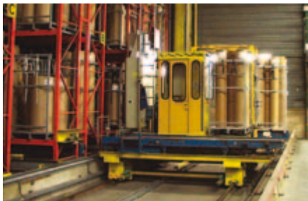
Positionnement de wagons à déplacement latéral
